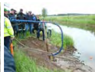
Spolning av dräneringsrör Foton: Magnus Halling
